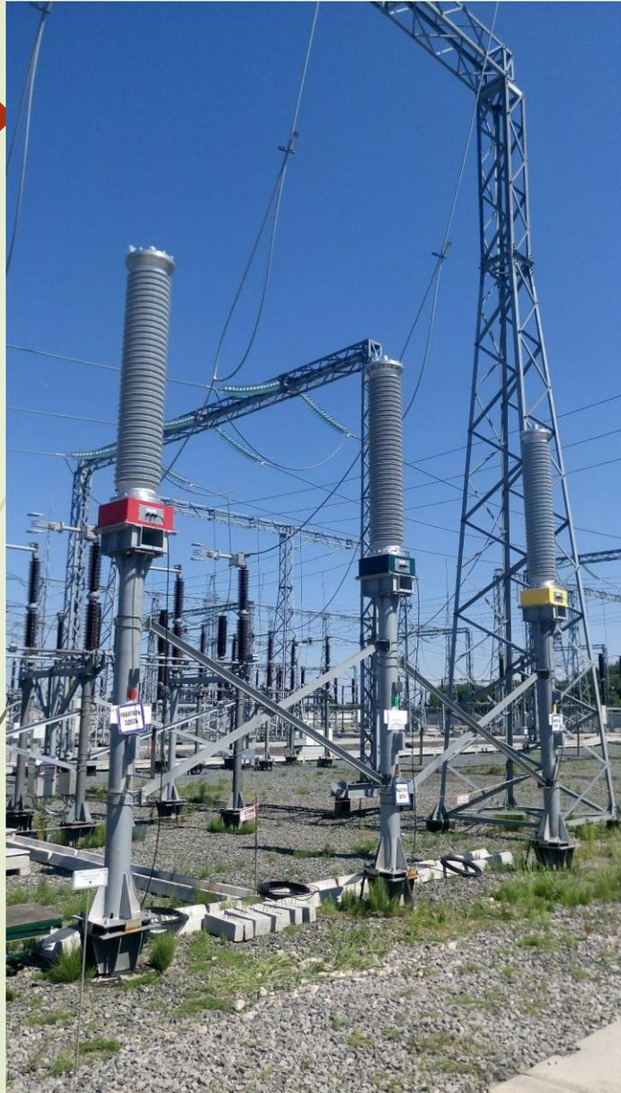
Опытный образец 3-х фазного оптического измерительного трансформатора 110 КВ на опытной подстанции ПАО «РОССЕТИ» (Нижегородская обл., 2019 г.)
